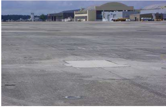
Pavement patch on apron.
